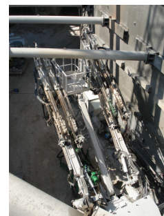
Figura 8. Doppia perforatrice assemblata su Robofore per l'esecuzione di fori ravvicinati
