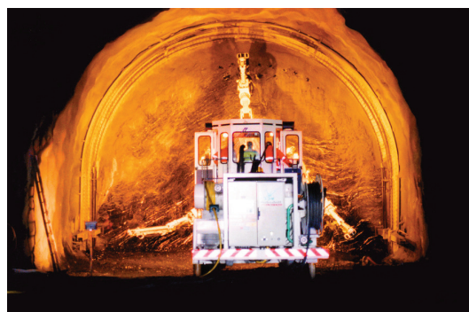
Figura 11. Jumbo Robofore 3 b
