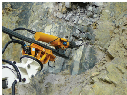
Figura 7. Utilizzo del rock splitter in pozzo
