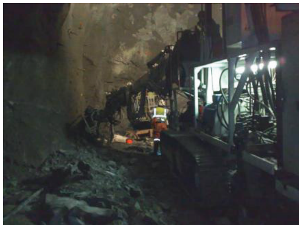
Figura 1. Jumbo robotizzato bibraccio cingolato al lavoro per la realizzazione di una galleria in rimonta per il progetto di Ingula in Sud Africa (CMC & IMPREGILO)
