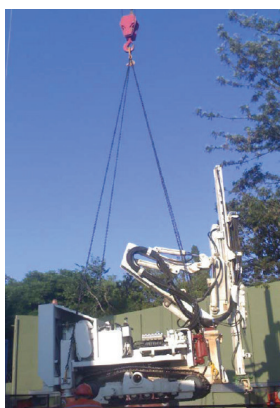
Figura 14. Jumbo speciale con cinematismi a ginocchiera per il calaggio all'interno del pozzo, idoneo ad eseguire perforazioni a geometrie variabili in ambienti ristretti
