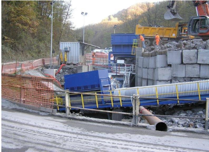
**Figura 4. Il nastro all'imbocco della discenderia; si noti la bocca di carico del frantoio**
