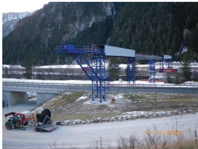
**Figura 14. Il nastro sopra la Statale S12 e l'Autostrada A22**
