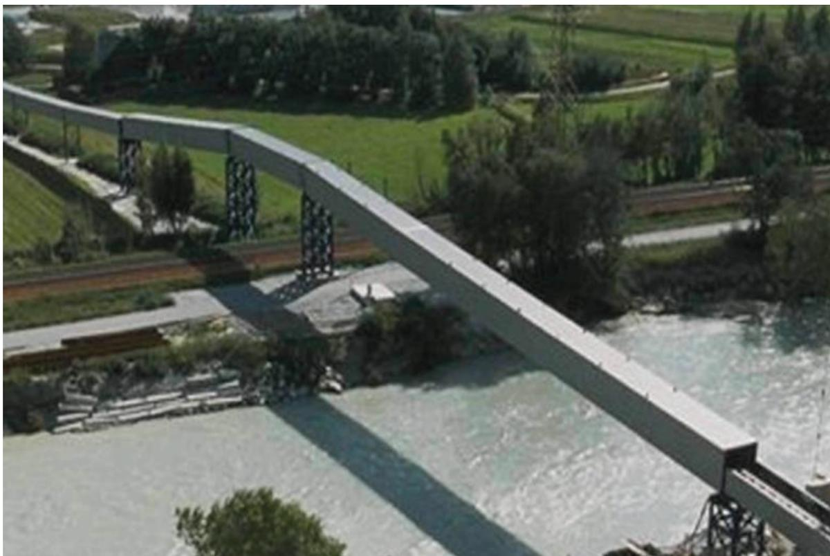
Figura 15. Tipico nastro con struttura chiusa
