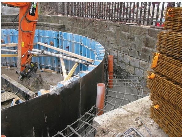
**Figura 5. (sx) Posa dell'armatura e cassatura del concio d'attacco**
