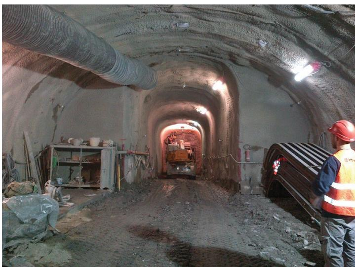
Figura 13. (sx) Vista d'insieme del Tunnel Pedonale durante la posa della rete elettrosaldata
