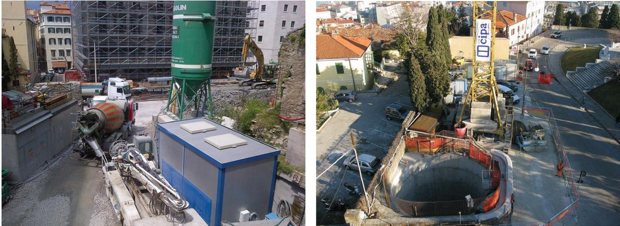
**Figura 3. - 4. Una veduta generale delle due aree di cantiere: a sinistra l'area di via del Teatro Romano durante il lavaggio dell'autobetoniera (sullo sfondo il deposito temporaneo dello smarino); a destra l'area di via Rota durante i lavori di scavo del pozzo.**
