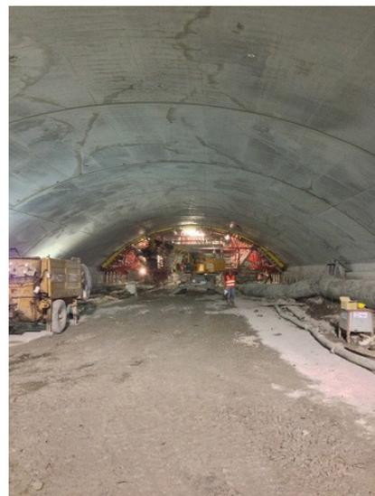
**Figura 11. (sx) Cassaforma per il getto della volta delle caverne**
