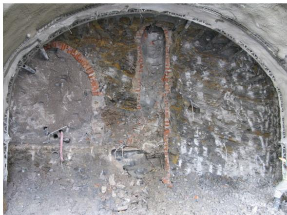
Figura 7. (sx) Interferenza di un cunicolo esistente e di un pozzo durante lo scavo del TI
