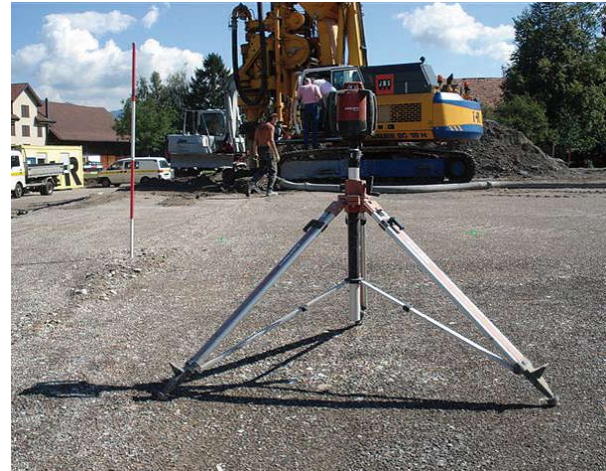
Figura 14 Tracciamento laser pali FDP (CH)
