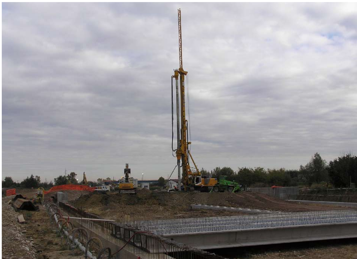
Figura 29 Si noti il well point a sinistra e la BG 28 al lavoro
