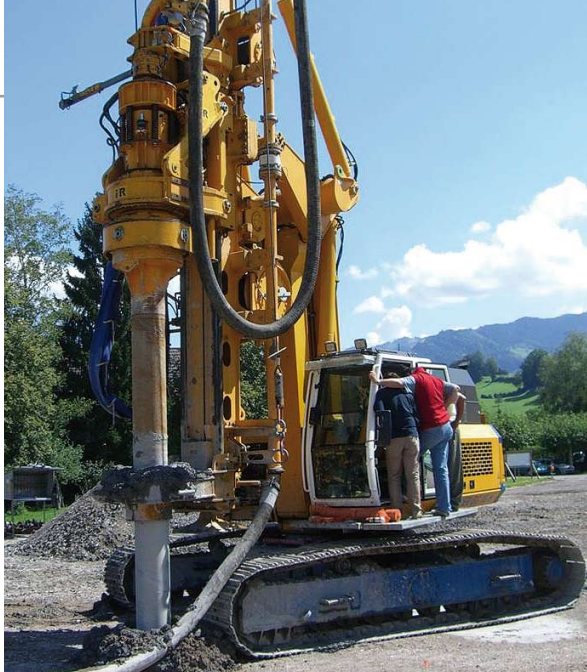
Figura 5 Si noti il minimo materiale di risulta prodotto da un palo FDP da 620 mm a 28 m di profondità
