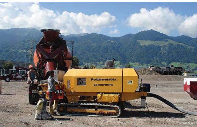
Figura 16 Pompaggio cls per palo FDP
