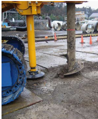
Perforazione del palo di contrasto
