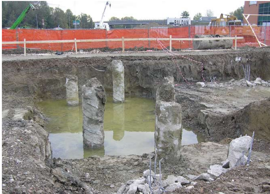
Figura 28 Pali realizzati prima della costruzione del plinto
