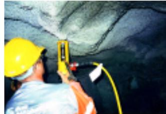
stato effettuato mediante una opportuna chiave dinamometrica bensì manualmente; ciò sottolinea l'importanza di utilizzare gli strumenti corretti per ottenere i risultati prefissati.
