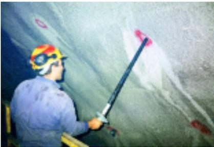
Figura 33 - Installazione manuale del Ct-Bolt
