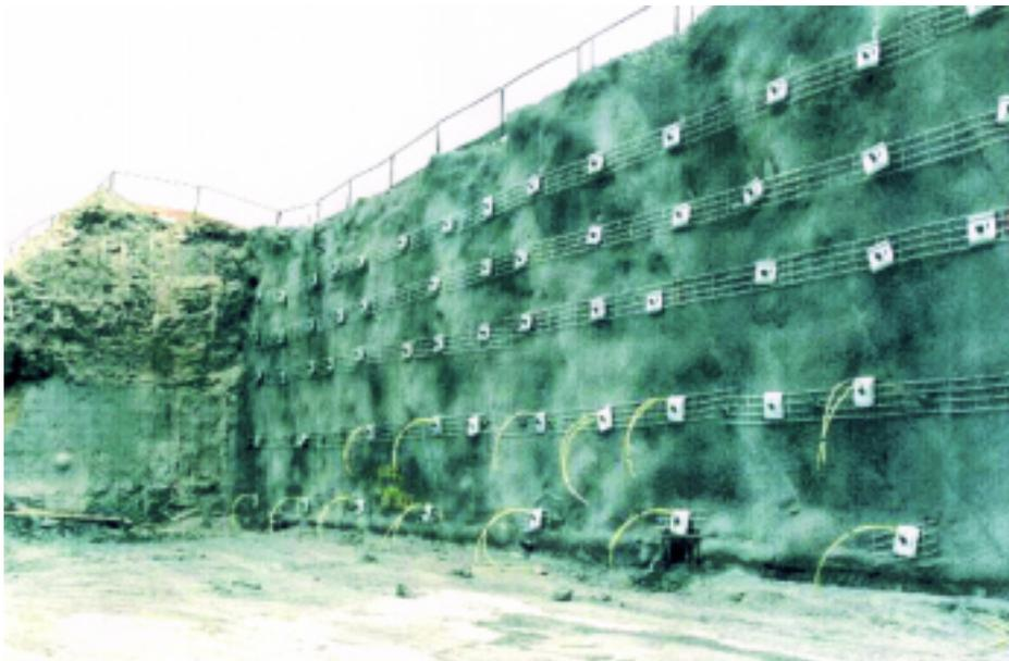
Figura 5 - Utilizzo di ancoraggi combinati CT-Bolt per il rinforzo di pareti verticali (Sydney, Sito Olimpico)
