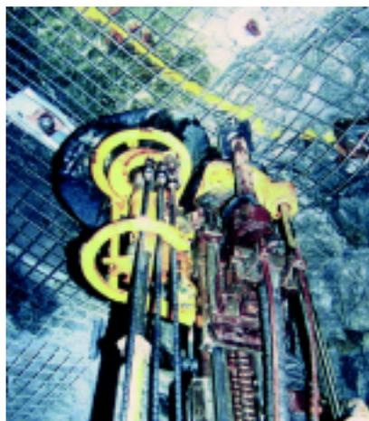
Figura 17 - Installazione automatizzata di un CT-Bolt
