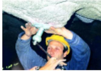
Figura 35 - Particolare della piastra semisferica a cupola
