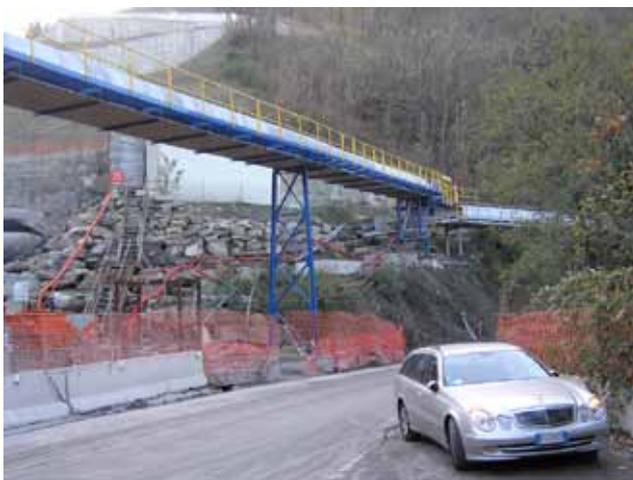
cadute accidentali di materiale, il nastro è protetto tramite una carenatura superiore avente anche la funzione di impedire il sollevamento di polvere lungo il percorso.
