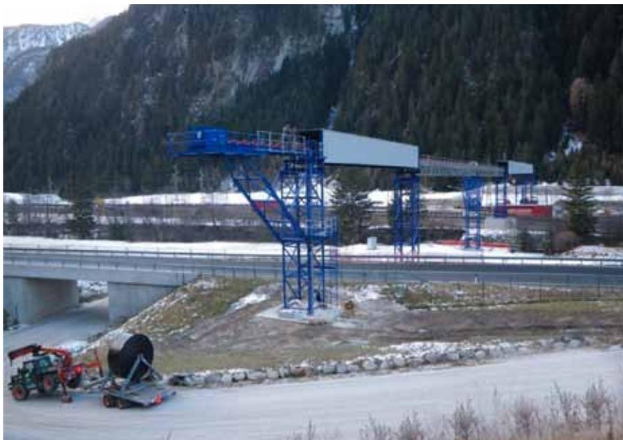
dine di progettare un impianto veramente particolare, in grado di oltrepassare tutti questi ostacoli in sicurezza e consentire una portata di 300 t/h con una pezzatura massima della grana di 250 mm.
