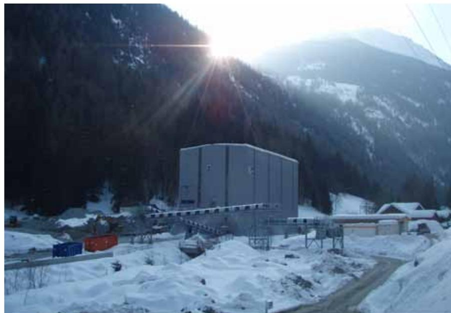
sistema a nastro, dimensionato per una portata di 1.000 t/h, e depositato, nella zona del portale, in una discarica intermedia a mezzo di un sistema di scarico orientabile (un "tripper" assemblato su di uno "stacker"); tale impianto è un tipico esempio di un sistema a nastro "ambizioso".
