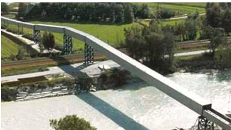
In corrispondenza dei ponti 3 e 4 si è inoltre prevista una copertura ed, in corrispondenza dei ponti 1, 2 e 5, è stato progettato il montaggio in un idoneo scatolare di protezione inferiore; in questo modo si è evitato anche il pericolo di caduta di materiale verso il basso.
