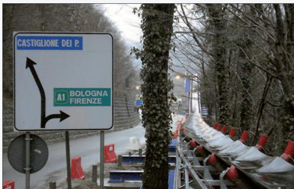
Figura 1 - Il nastro esterno alla discenderia della galleria di base della Variante di Valico (FI-BO)
