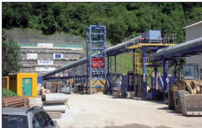
Figura 10 - L'imbocco di Aica con il nastro Marti Technik in funzione
