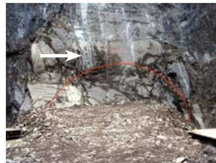
(da uno degli imbocchi e su due fronti utilizzando la via di fuga come accesso); è stato utilizzato un jumbo robotizzato a 3 braccia classe Robofore (n. 448) ed un jumbo Pantofore a 2 braccia. Il sostegno ha previsto chiodature tipo Swellex, spritzbeton senza fibre ed armatura quadra, centine costituite da due IPE 160 affiancate e preinfilaggi lunghi 12 m per le prime volate presso gli imbocchi. Lo smarino è stato effettuato con pale cariatrici e camion.
