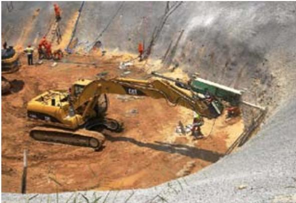
Sistema di perforazione automatico Robodrill CPA, assemblato su escavatore CAT 320, adibito alla chiodatura delle paratie di realizzazione delle stazioni in sotterraneo. L'attrezzatura presenta anche un depolverizzatore ed è insonorizzata; sta funzionando con gestione tramite operatore a terra
