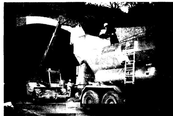
**FIG. 3** - Fase di carico cemento Ecospritz confezionato in big bags da 1.000 kg, su miscelatore volumetrico Blend, GeoTunnel, Cantiere Galleria Seglia, Ventimiglia
